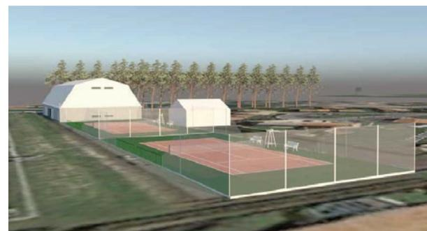
Le bâtiment (couverture) sera composé d'un seul volume en forme polygonale en toile tendue de couleur blanche. Il aura une superficie d'environ de 648m<sup>2</sup> (18m x 36m) et respectera le gabarit FFT.
